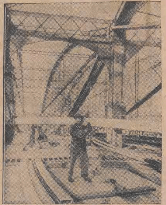
W „mieście żelaza“ Pittsburgu (Stany Zjednoczone) po raz pierwszy w dziejach budowy mostów istniejący most wyłożono pokładem z aluminium. Na zdjęciu robotnik z tregrem aluminiowym wagi 104 funty, zastępującym treger stalowy tej samej wielkości — wagi 292 funty.
