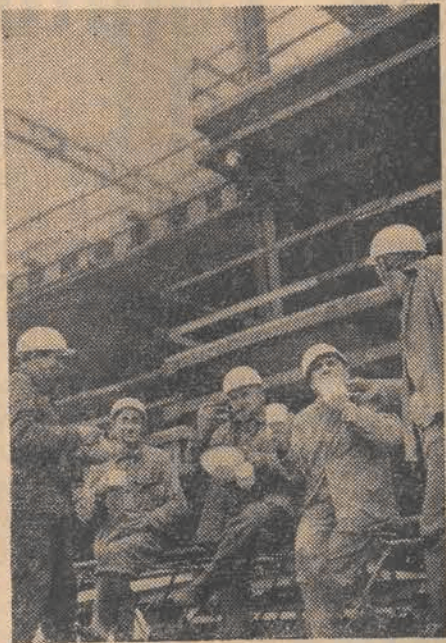
Robotnikom wyraźnie smakuje zupa dostarczana na budowę Centrum G-3 przy ul. Głównej.
