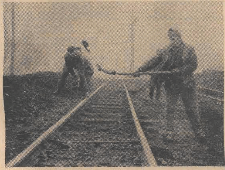
Tym żołnierzom z pułku OT im. T. Głabskiego, pracującym przy układaniu torów w al. Politechniki, podczas przerwy śniadaniowej tak-że zapewnia się posiłek regeneracyjny. Fot.: A. Wach
