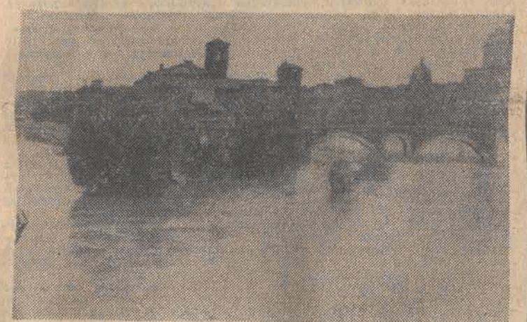
Ulewne deszcze, które przeszły nad Włochami podczas ostatnich dwóch dni, spowodowały podniesienie się wody w Tybrze do poziomu grożącego powodzią. N/z: wezbrany Tybr pod Rzymem. CAF — AP — telefoto
