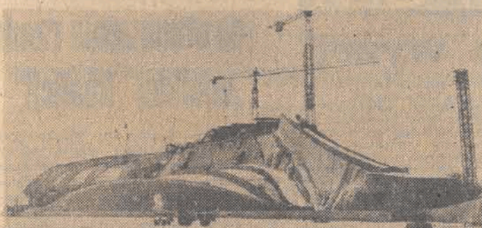
Na zdjęciu: widok od zewnątrz na budowę Stadionu Głównego CAF - Lehtikuva
