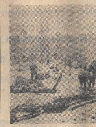
Brygady Miejskiego Przedsiębiorstwa Komunikacyjnego usuwają tory tramwajowe na ulicy Głowne. Wkrótce wytyczono zostanie nowe torowisko i ułożone nowe szyny na pasie wydzielonym dla tramwajów między jezdniami jednokierunkowymi powstającej Trasy W-Z. Fot.: Katedra
