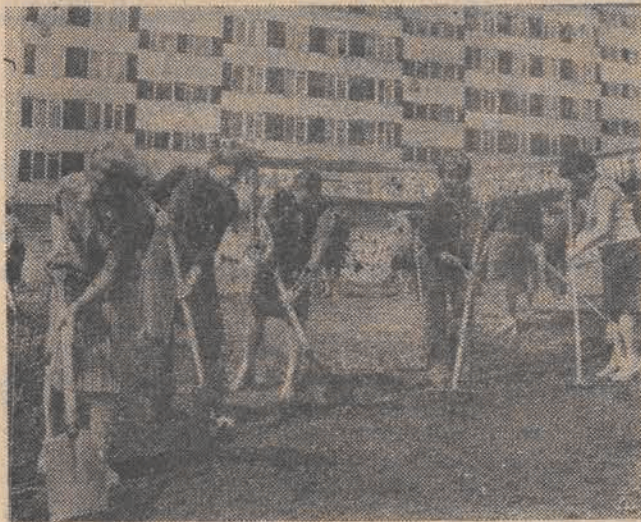
Przy budowie drugiej jezdni ul. Zgierskiej pracowali m. in. członkowie partii i ZSMP z ZPB im. Sz. Harnama.
