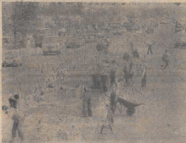
Na budowie nowoczesnej arterii wylotowej w kierunku Piotrkowa — ul. Rzgowskiej, pracowali przedstawiciele kilkudziesięciu zakładów. Na zdjęciu: prace na granicy miasta.
