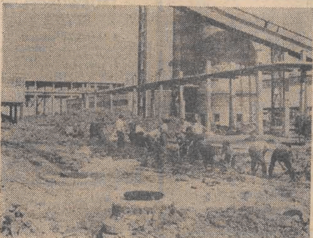
W stolicy województwa największym frontem robót był teren budowy Fabryki Domów. Czyn Partyjny trwa tu już od dwóch tygodni. Wczoraj w Fabryce Domów pracowali członkowie wojewódzkiej instancji partyjnej i Urzędu Wojewódzkiego.
