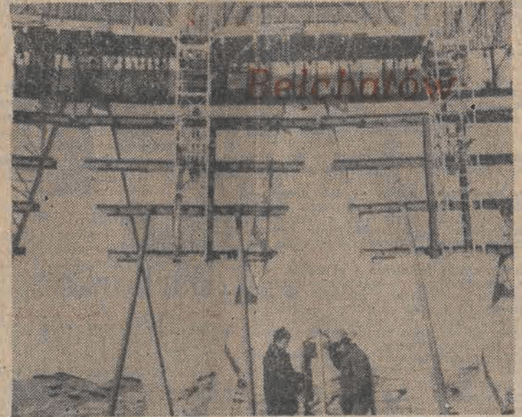
Wraz z budową kotłowni w Beichatowie (woj. piotrkowski), trwa wzniesienie elektrowni. Obecnie zakończono prace fundamentowe 400-metrowego komina i prowadzone są roboty przy montażu konstrukcji stalowej wieży nośnej kotła nr 1. N/Z: montaż rusztowań. CAF — Zbrannecki — telefoto
