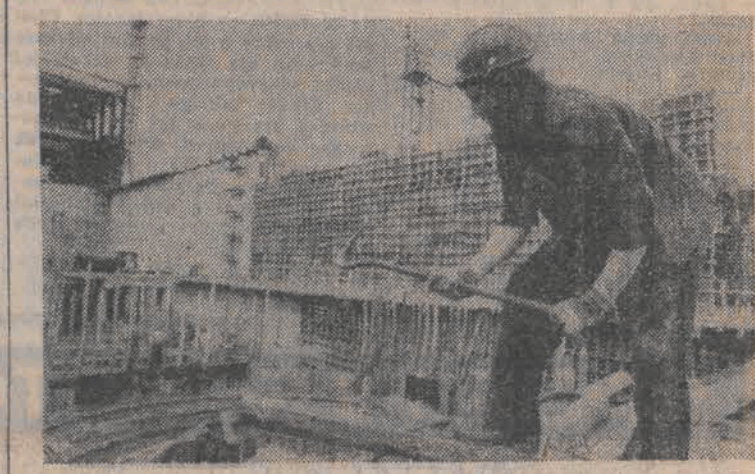
Trwa budowa elektrowni szczytowo-pompowej nad jeziorem Żarnowieckim (woj. gdańskie). Będzie ona posiadać 4 bloki o mocy 170 MW każdy. Pierwszy turbozespol powinien dać prąd w 1980 roku. Obecnie większość robót koncentruje się przy wznieszeniu słowni, gdzie prowadzone są prace przy szalowaniu fundamentów turbin. CAF — Ukielewski — telefoto
