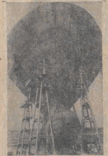
W Stoczni Im. Komuny Paryskiej w Gdyni budowany jest statek RO-RO dla armatora norweskiego, o nośności 22 tys. ton. N/z: przeniesienie bloku dziobowego dźwignica bramowa.
