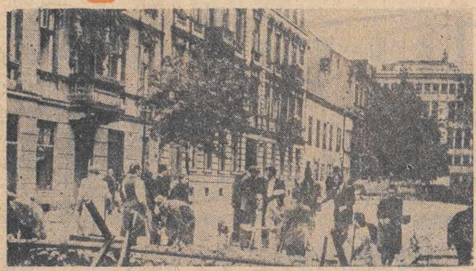
Budowa barykady przy ul. Solnej
