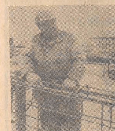
Na budowie nowoczesnej bazy kontenerowej w Porcie Gdynskim roboty trwają na wielu odcinkach. Pierwszy statek ma tu zacumować w październiku tego roku. Przy realizacji tej inwestycji uczestniczy wielu wykonawców z całego kraju. N/z: na budowie estakady przy pracy zbrojarze Krzysztof Gorlikowski i Józef Ciszewski.
