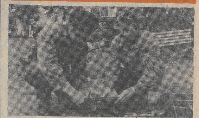
W tegorocznych zrywach zaangażowano wielką ilość sprzętu zmechanizowanego. Nad jego sprawnością czuwają ekipy remontowe, gotowe w każdej chwili do wykonania niezbędnych napraw. Wspomagają je w czynnie społecznym wojskowe zespoły zabezpieczenia technicznego. Niz: kpr. Józef Adamowicz wspólnie z kier. warsztatów mechanicznych w PGR Namysłów (woj. opolskie) Edwardem Grzędą przygotowują tańce napędowe do wymiany w jednym z kombajnów zbożowych typu „Bizon”. CAF — WAF — Szczepaniak — telefona
