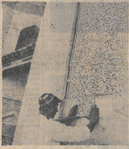
Wykładanie fasady medresy Muhammeda Amira-chana płytkami majolikowymi. CAF - TASS
