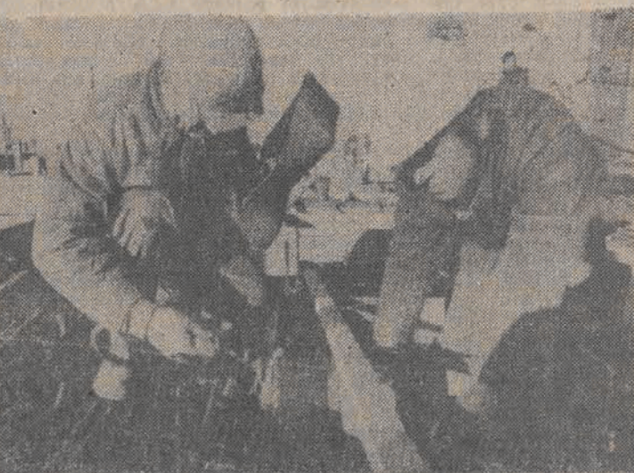
W Brzezinie nad Odrą powstaje elektrownia „Opole”. Obecnie prace koncentrują się przy wznoszeniu konstrukcji nośnej pierwszego bloku...
