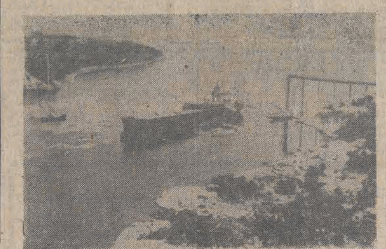
Pliny pod liberyjską banderą norweski frachtowiec „Star Clipper” zatonął w wyznaczonym kursu w Gestej mgie i zawadził o rafę mostu. Most długości prawie 300 metrów runął do wody w pobliżu Goetehoru. Prawdopodobnie zginęło 10 osób. CAF - UPI - telefoto
