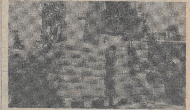
31 sierpnia ruszyły prace przedludkowe przy nabrzeżach Portu Szczecińskiego. N/Z: przy zakładku na m/s „Wejherowo” pracuje brzośda Władysława Staszewskiego. CAF - Undro - telefoto
