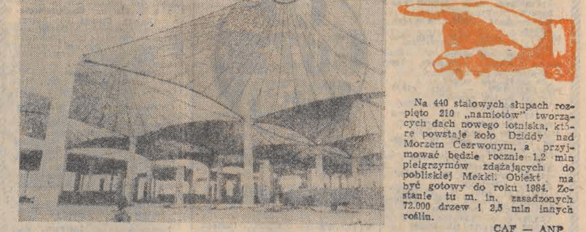
Na 440 stalowych słupach rozpięto 210 „namiotów” tworzących dach nowego lotniska, które powstaje koło Dziwdy nad Morzem Czerwonym, a przyjmować będzie rocznie 1,2 mln pielgrzymów zjadających do pobliskiej Mekki. Obiekt ma być gotowy do roku 1984. Zostało tu m. in. zasadzonych 72.000 drzew i 2,5 mln innych roślin.
