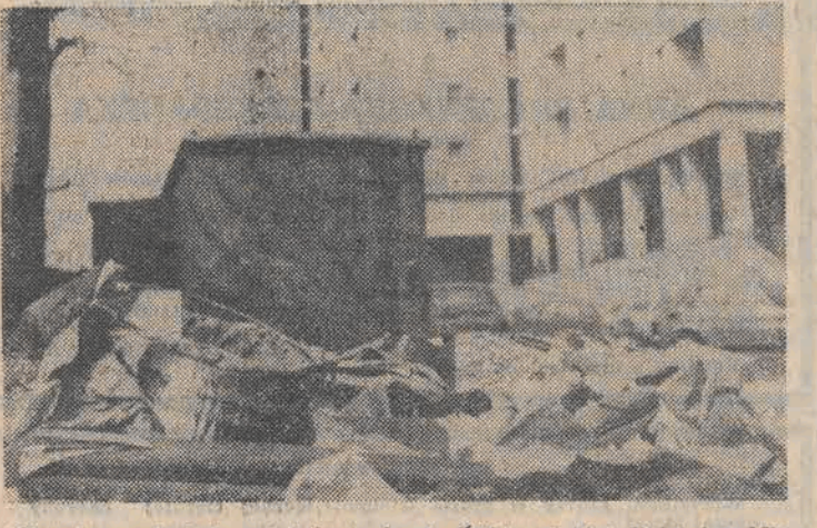
Okazale wyglądają z daleka budowle Śródmiejskiej Dzielnicy Mieszkaniowej. Gorzej jest w różnych kątach i zakamarkach wokół naszego „Manhattanu”...
