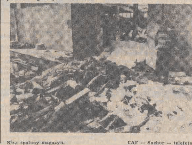
N/Z: spalony magazyn.
