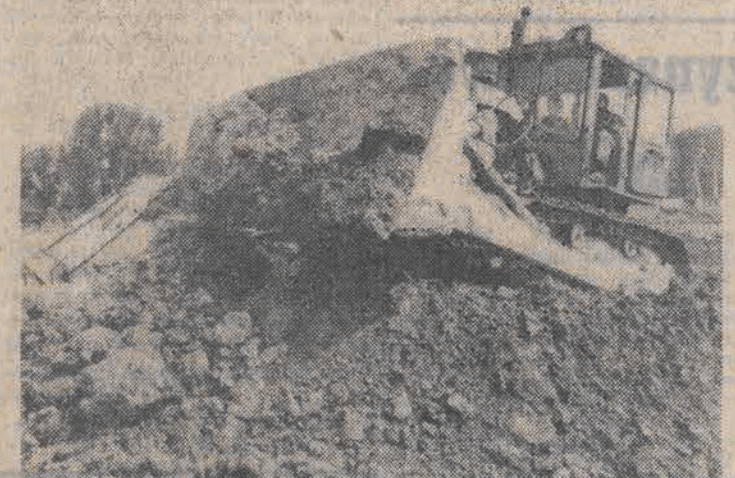
Na zdjęciu: prace ziemne na budowie Centrum. CAF — A. Zbraniecki — telefoto
