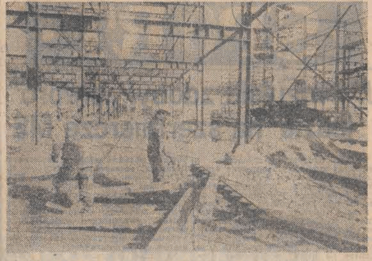
Na budowie Elektrowni Jądrowej w Żarnowcu prowadzi się intensywne roboty niwelacyjne, buduje drogi dojazdowe i zaplecze socjalne (stołówka, łazienki, szatnie). N/Z: budowa konstrukcji stołowej centralnej i czterech szatni.
