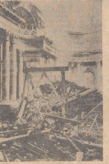
Sala Wielka Ansamblowa po pożarze w 1939 r.
