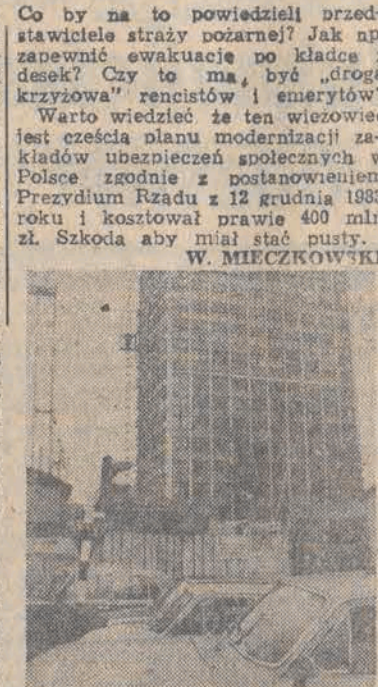
Budynek ZUS będzie ładny, a balkon zostanie... FOTO: A. WACH
