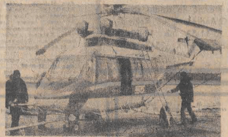
Specjaliści z radzieckiego Instytutu Badań Lotnictwa Cywilnego testują nowy helikopter polskiej produkcji V-3 Sokół. Helikopter ten produkowany jest w wersji pasażerskiej, ratowniczej i tonyrowej. Może on latać na wysokości 3000 metrów z szybkością 290 km na godzinę. Jego zasięg wynosi 300 km. Na zdjęciu: Sokół V-3 przed próbnym lotem.
