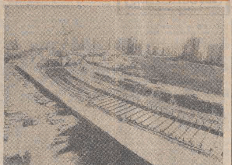
Szybko postępują prace na budowie warszawskiego metra. Na Ursynowie plac budowy przeciąga się na odcinku 4 km, od ulicy Nugat do ulicy Wałbrzyskiej (w osiedlu Stuzew Nad Dolinka). N/z: ogólny widok budowy na Ursynowie. CAP — K. SITEK
