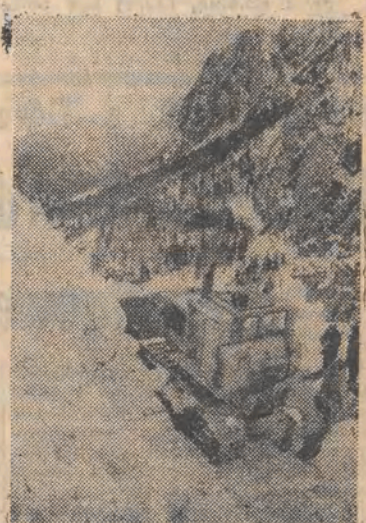
Ciętki buldożer przekopuje zasypaną śniegiem drogę do będącej w budowie hydroelektrowni Chudon w Gruzji, w rejonie dotkniętym opadami śniegu i lawinami.
