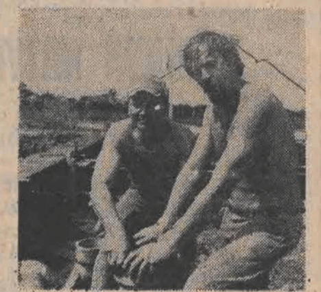
Na Węgrzech nawet wrześniejsza pogoda sprzyja budowlanym — twierdzą Stanisław Górecki i Antoni Stpka. FOTO AUTORA
