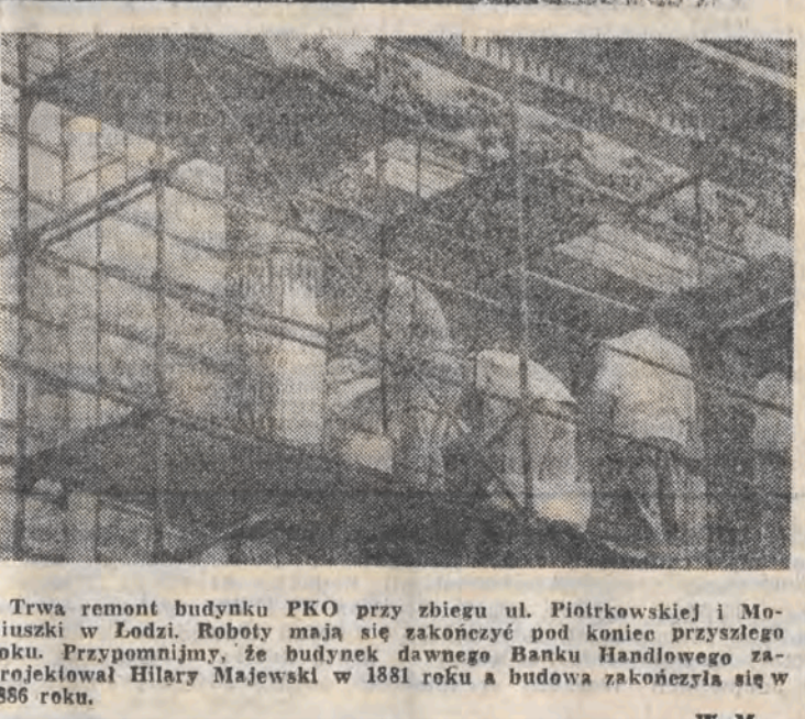
Trwa remont budynku PKO przy zbiegu ul. Piotrkowskiej i Mońskiego w Łodzi.
