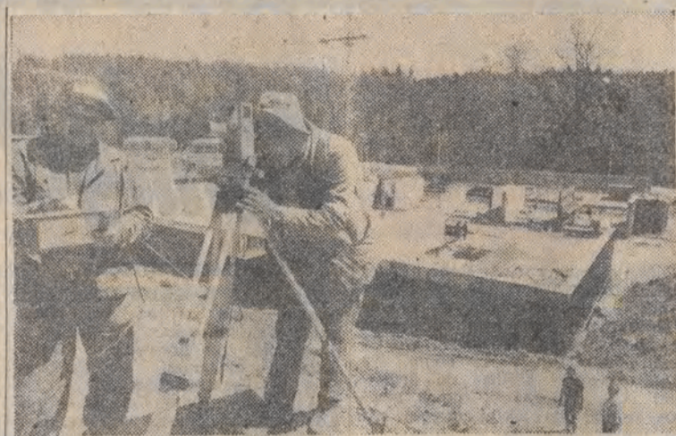
CSRS. W miejscowości Cesky Krumlov koło Budziejowic „Budimex” prowadzi budowę biologicznej oczyszczalni ścieków o mocy przerobowej 100 tys. m szece. Na dobę. Jest to, jak dotychczas, największy kontrakt tej polskiej firmy, na ponad 100 mln rubli transferowych. Na budowie zatrudnieni są wyłącznie Polacy, a techniczny projekt jest także polski. Inwestycja przekazana będzie do użytku we wrześniu 1991 r. Nż: prace przy tzw. tyczeniu obiektów przy pomocy teodolitu. Od lewej: inż. Ryszard Luczak oraz inż. Jarosław Mic z PRI w Olsztynie. CAF — S. MOROZ
