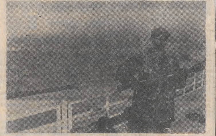
TURCJA. 13 bm. wody Eufratu przestały płynąć na południe do Syrii i Iraku, ale spiętrzone przez wielką tamę Atatürk, napełniają sztuczny zbiornik. Operacja ta trwać będzie przez miesiąc i prowadzona jest pod osłoną wojska.
