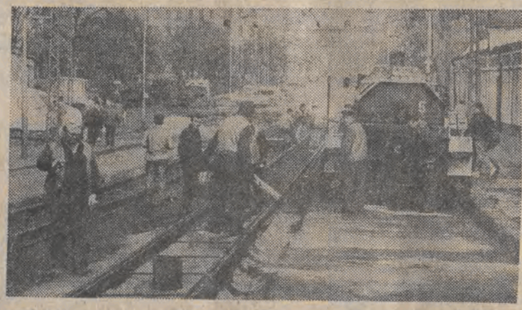
Roboty torowe w rejonie pl. Niepodległości i ul. Rzgowskiej zostaną zakończone prawdopodobnie w tym miesiącu. W Łodzi powinno się wymienić znacznie więcej szyn niż robi się to obecnie. Z części prac MPK jednak rezygnuje — nie starczy pieniędzy... FOT.: A. WACH
