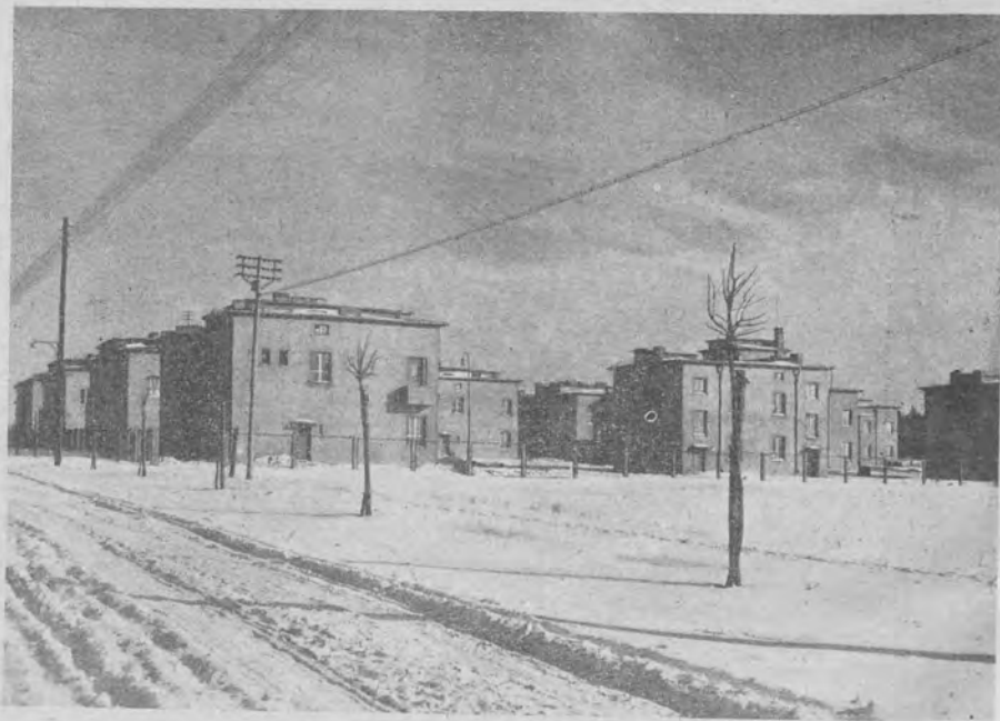
Kolonia Urzędników Miejskich przy ul. Tłackiej
