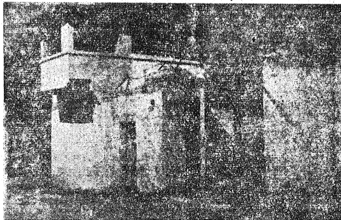
Główne wejście do więzienia w Radogoszczu, gdzie SS-manni przed opuszczeniem Łodzi żywcem spalili 3000 więźniów.
