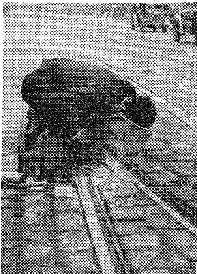
Włoszenie porządku. Spawacz z palnikiem acetylenowym na ul. Piotrkowskiej — przy pracy. (Fot. J. Płazewski)
