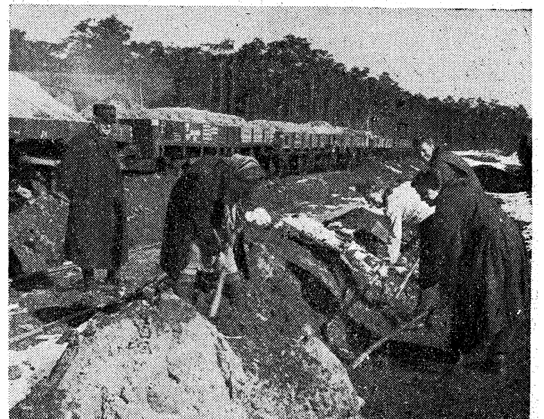
Ważna stacja przeładunkowa — Pyskowice na Śląsku rozbudowuje się coraz szybciej. Obecnie układa się boczny tor. Wśród robotników przeważają kobiety, gdyż prawie wszyscy mężczyźni pracują w pobliskich kopalniach.
