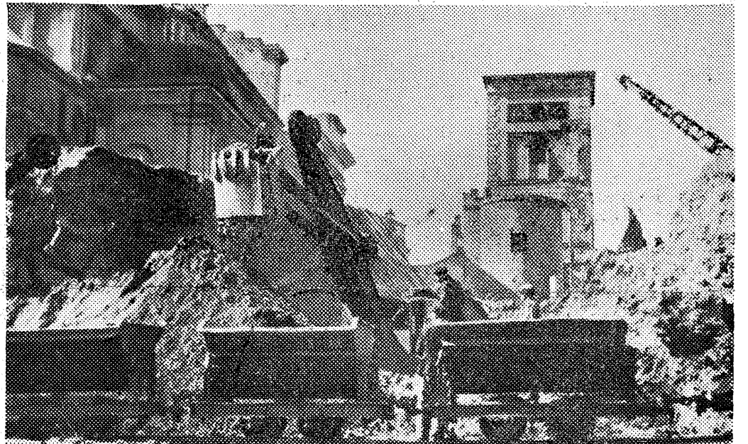
Prace nad oczyszczaniem terenu przy budowie mostu śląskiego na Wiśle w Warszawie (dawniejszego mostu Kierbedzia).
