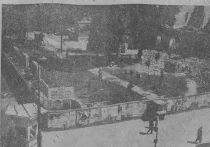
Tak wygląda obecnie teren przy zbiegu Al. 3 Maja i Nowego Świata w Warszawie, na którym stanie „Wspólny Dom” zjednoczonych partyj robotniczych. Obecnie trwają prace przygotowawcze.
