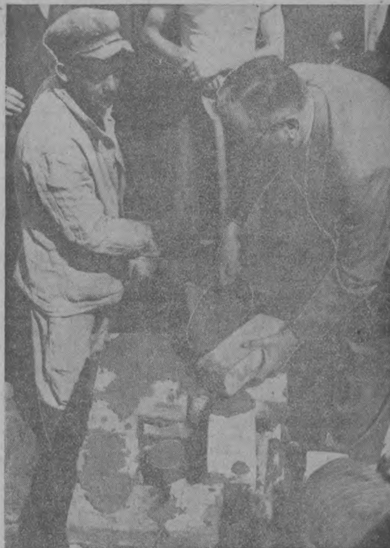
W dniu Święta Spółdzielczości położono kamienie węgielne pod nowe osiedla mieszkaniowe W.S.M. w Warszawie. Min. Odbudowy Kaczorowski przy zamurowywaniu aktu erekcyjnego.
