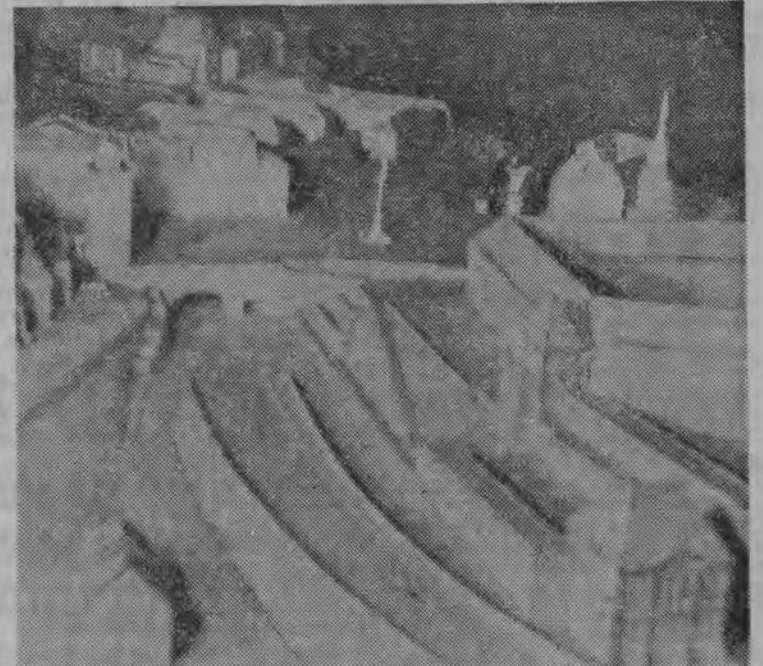
Tak będzie wyglądała trasa Wschód - Zachód w Warszawie. Na zdjęciu widoczny wjazd do tunelu, na prawo Zamek Królewski, w głębi kolumna Zygmunta. (Do artykułu na str. 5) (foto API)
