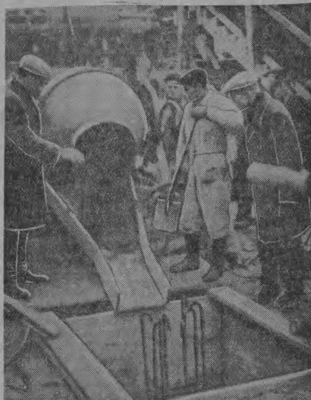
Akt erekcyjny domu PZPR po założeniu go w fundamenty gmachu został zabetonowany. — Na zdjęciu moment wy- lewania betonu z betoniarce. (Foto APD)
