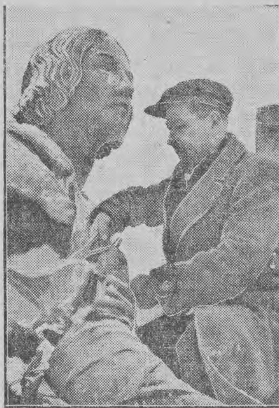
Pomnik Kopernika, który został poważnie uszkodzony podczas Powstania Warszawskiego znów stanie na swoim miejscu. Na zdjęciu: prace wstępne przy rozmontowywaniu posągu, który będzie przywieziony do odlewni firmy B-ci Łopieńskich gdzie przeprowadzone będą prace renowacyjne.
