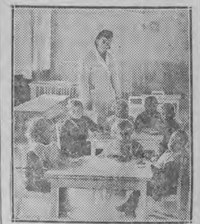
Wnętrze przedszkola miejskiego w Zgierzu
