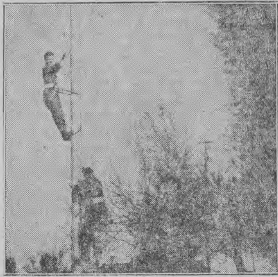
Zakładanie przewodów dla celów radiofonizacyjnych
