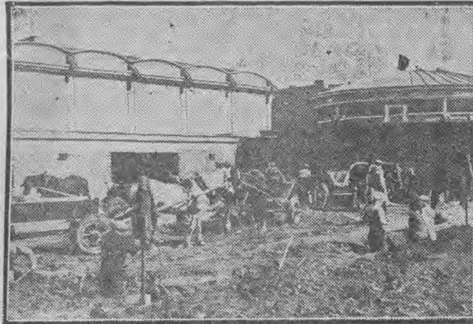
Ostatnie roboty przy budowie nowego kina, które zostanie dziś otwarte w Warszawie przy ul. Narbutta.
