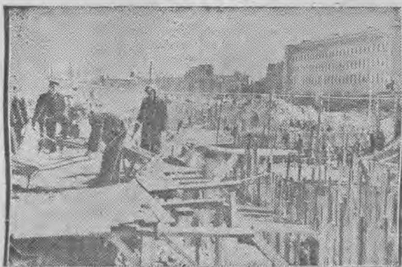
Betonowanie fundamentów gmachów osiedla robotniczego „Muranów”.
