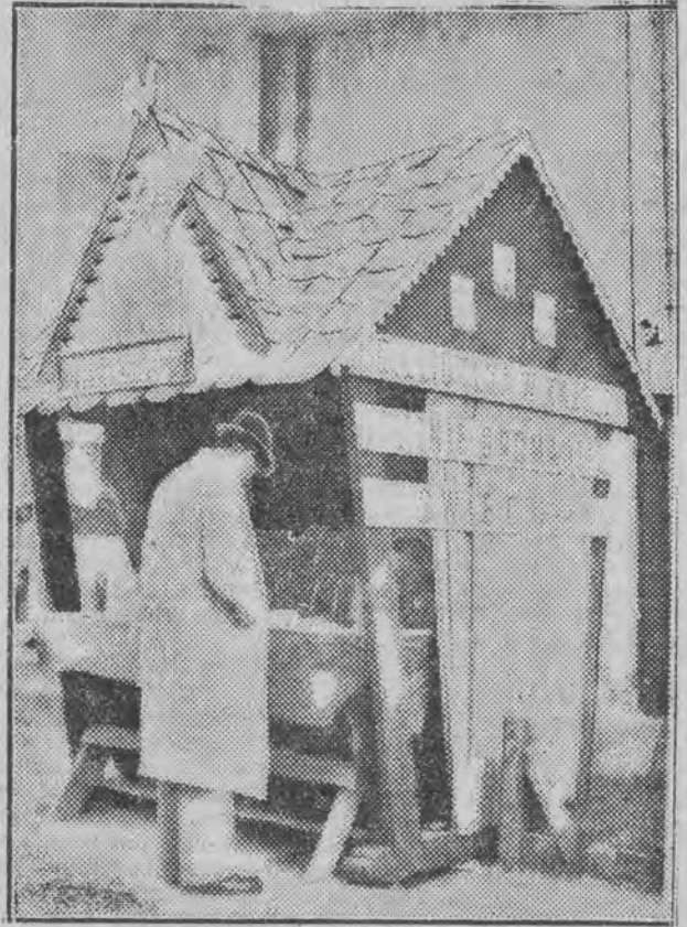
Foto AR Estetyczny kiosk księgarski w Warszawie, przy Al. Jerozolimskich.
