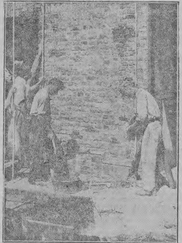
W sobotę dn. 21 bm, zespół tynkarski II Oddz. PPBOR pod kierownictwem Władysława JÓZKO, ustanowił nowy ogólnopolski rekord, pokrywając tynkiem w czasie 6 godzin 5,14 mtr. muru. Ustanowienie rekordu zostało umożliwione przez zastosowanie (wg. pomysłu Edwarda FRONCZAKA) stalowych listew, pozwalających na znaczną oszczędność czasu pracy. Na zdjęciu Władysław Józko narzuca zaprawę, obok Franciszek Fronczak montuje następną listwę.
