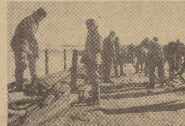
Zolnierze wojsk kolejowych i KRW Pomorskiego Okręgu Wojskowego przystąpili do rozbiórki starego drewnianego mostu na Wiśle, łączącego Chelmino ze Świeciem. Rozbiórka podkrotowana jest koniecznością ochrony nowego mostu, znajdującego się w sąsiedztwie rozbiernego. Prace prowadzi się w ramach akcji przeciwpowodziowej. Ochrona mostu w czasie zagrożenia powodzią kosztowałaby drożej, niż rozbiórka. Obecnie ehołdzi o to, by zdążyć rozbić most przed nadejściem kry i wysokiej wody. CAF — fot. GHI
