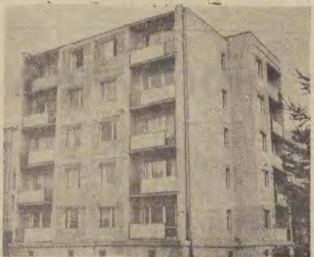
Ul. Sporna 85, blok 101a. Autor projektu — mgr inż. arch. Jan Michałowicz, kierownik budowy Edward Kowalski. Wznosili pracownicy LPBM nr 3.
