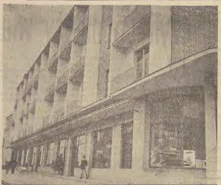
Budynek nr 53 ul. Rogozińskiego 23 na Nowym Rokicju projektowała mgr inż. arch. Mina Hailigowa. Roboty wykonywali pracownicy LPBM nr 1, którymi kierował inż. Stanisław Kożuch.
