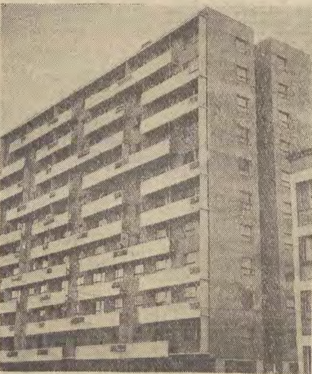
Nowe Rokicie, ul. Przyszkoła 13, blok 33. Projekt mgr inż. arch. W. Minccha (Warszawa). Kierownikiem budowy był inż. Tadeusz Ogrodowczyk z LPBM nr 1.
