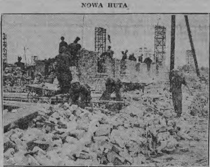
Pod Krakowem w pobliżu budowy zakładów przemysłowych „Nowa Huta“ w rekordowym tempie rośnie wielkie osiedle mieszkalniowe. Na zdjęciu: na terenie budowy pracują Ochotnicze Brygady ZMP.
