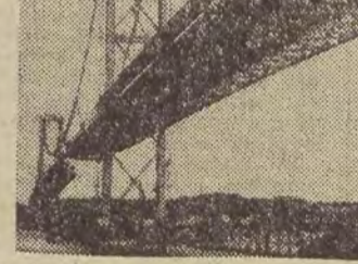
Budowa - 4 co do długości w świecie - wiszącego mostu drogowego nad zatoką Firth of Forth (Wielka Brytania), który zostanie oddany do użytku latem przyszłego roku. Jezdnia mostu przebiega na wysokości 54 m nad powierzchnią wody. CAF
