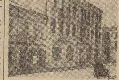
Zniszczony dom w Rynku. Ma być przebudowany na Dom Kultury
